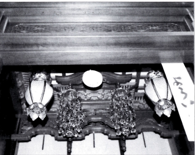
仏壇の天井からぶら下げようにして簡単取り付け 経机上の炎も感知する（中原三法堂）
